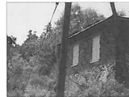
I_01: ΝΟΤΙΑ ΠΛΕΥΡΑ
