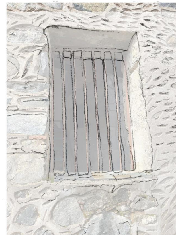
Σιδεριά(Αλλοίωση λόγω βάρους)
